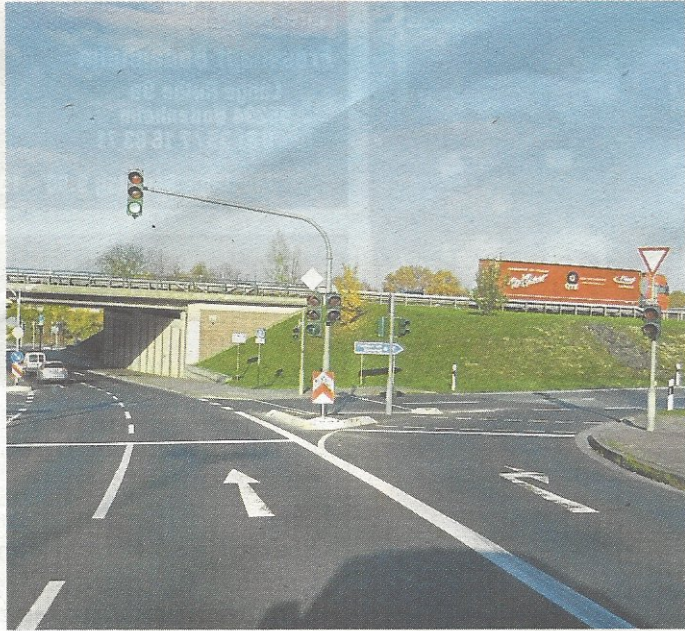
Nicht ganz ungefährlich ist der offizielle Schulweg der Grundschüler, der die Ein- und Ausfahrt der Autobahn A60 kreuzt. Foto: Karin Weber
